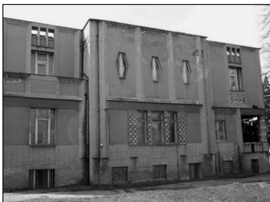
Pohled ze silnice na vilu.
